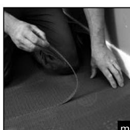
**Photo (a) :** le BOLON doit être posé de façon rectiligne. Pour vous aider, faire un tracé à 1,96 mètre du mur au Cordex.
